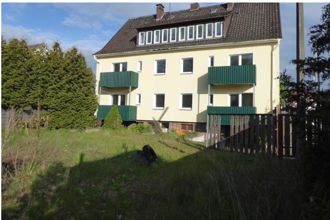
Abb. 4: Einzelhaus (OEL) mit Ziergarten (PHZ) der Itener Str. 17 (Blickrtg. Nord, Foto: ALAND, Herbst-Heumann 21.04.2021)
